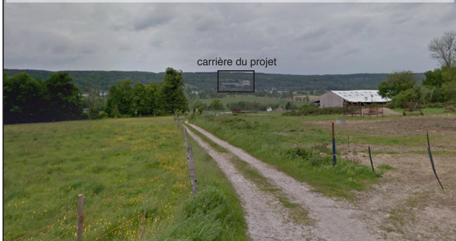
Le GR3 à St-Pierre-de Manneville (LD Le Moulin) : le site du projet situé à 2 km en face sur le versant opposé est visible (flancs crayeux de la carrière)
